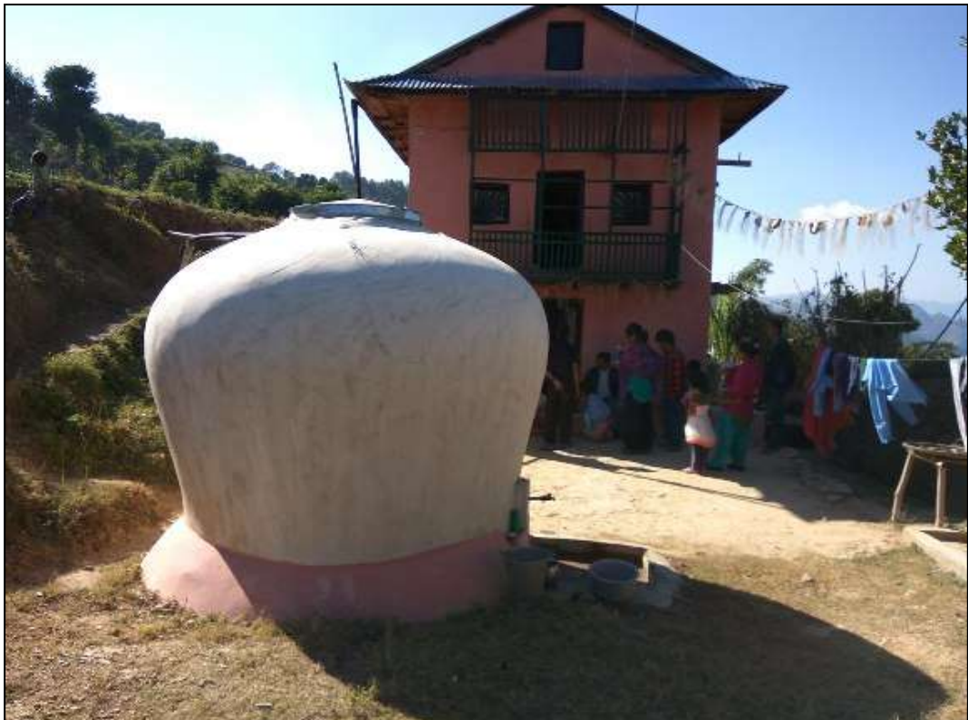
तिराम घैटे ट्यांकी निर्माण योजना तिराममा निर्माण भएको घैटे ट्यांकी
