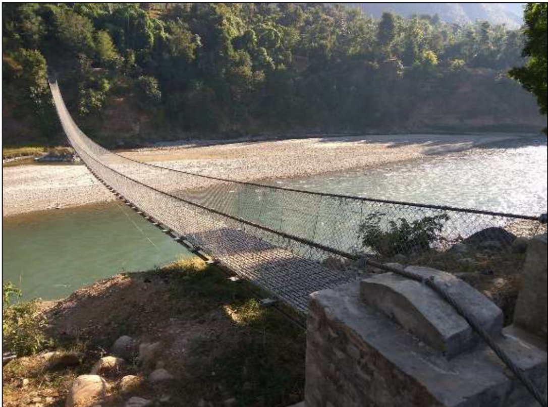
निर्माण सम्पन्न भएको लामाचौर भोलुङ्गे पुल
